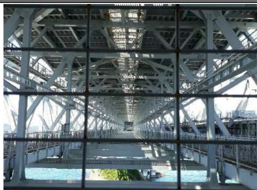
8/8 大鳴門橋的內部
