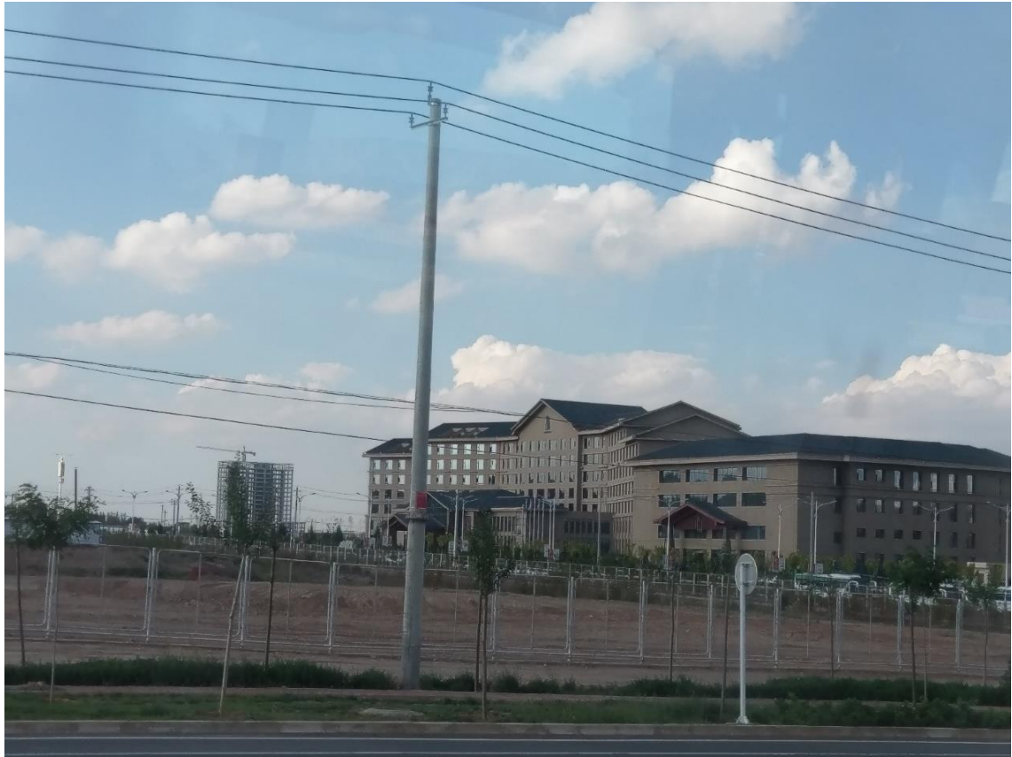
建設中的蘭州新區
